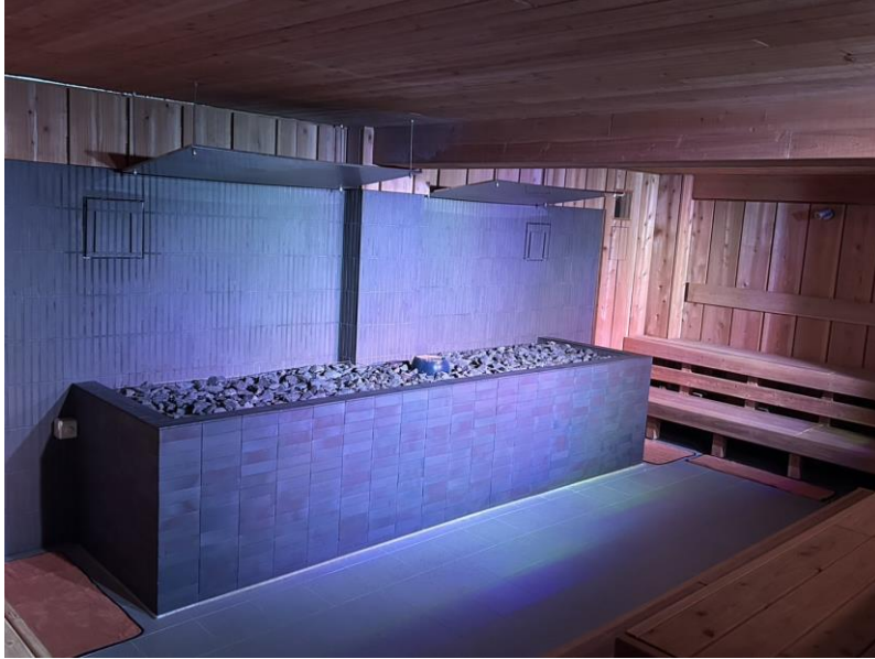
【LM70S # 1 ~ 4】4機使用し全体を照らす
