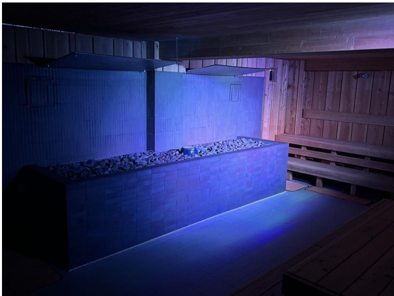
【LM70S # 1 ~ 4】2機使用し中心のみ照らす
